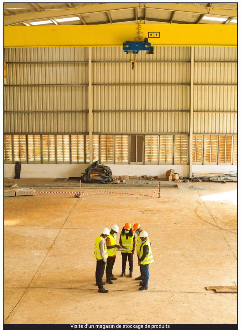
Une vue de l'espace de stockage du manganèse
